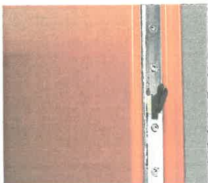
Sikkerhedsdør S43 har en flerpunktlås, hvor hovedlåsen suppleres med låserigler foroven og forneden.
